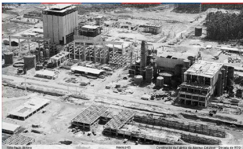
Imagem 7: Construção da fábrica de Aracruz Celulose no município de Aracruz. Fonte: Arquivo digital da Aracruz
