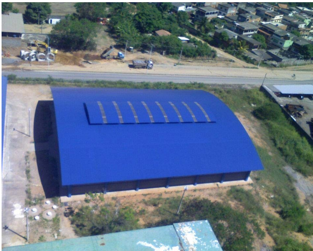
Figura 17 - Vista superior do ginásio de esportes em fase de acabamento interno
