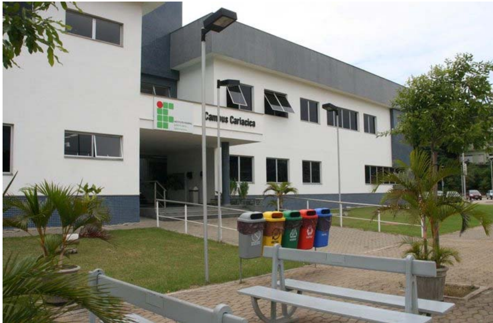
Figura 15 - Vista da entrada do Prédio I
