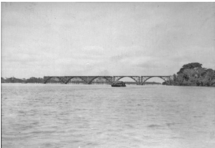
Construção da ponte Getúlio Vargas - Linhares - 1952
